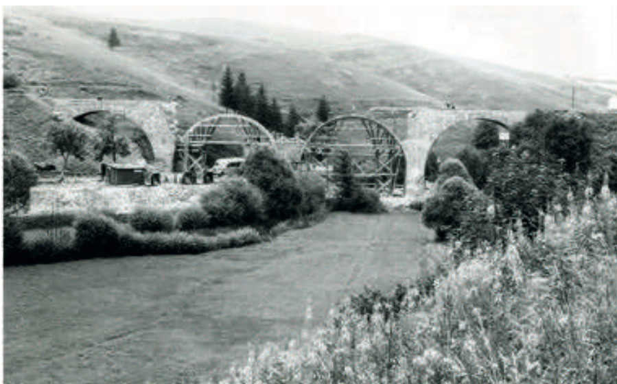
Wiederaufbau des Freilinger Viaduktes, um 1949 / 50 (Lichtbildstelle BD Köln, Slg. Hansjürgen Wenzel)
