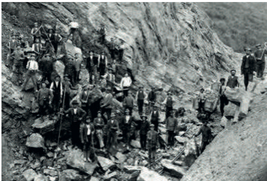
(Foto: Bahnbau bei Freilingen, Sammlung Erwin Mungen)
